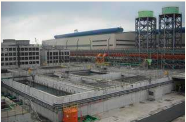
中龍煉鋼水場
