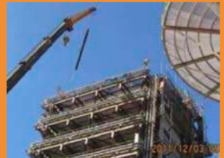
中龍第一燒結場SCR第五層觸媒添加案
