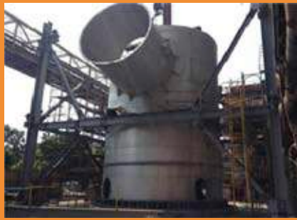
中鋼四號燒結工場增設廢氣脫硫系統
