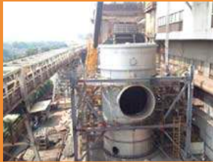
中鋼四號燒結工場增設廢氣脫硫系統
