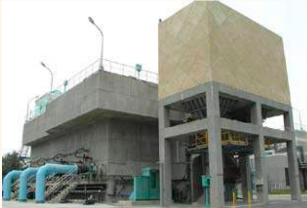
流體化床結晶軟化系統
