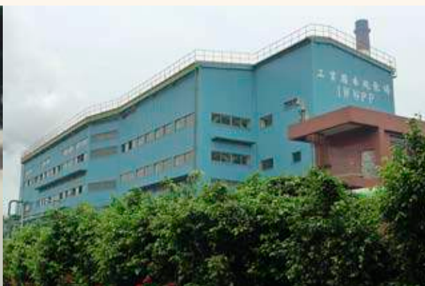
中鋼工業廢水回收純化場外觀
