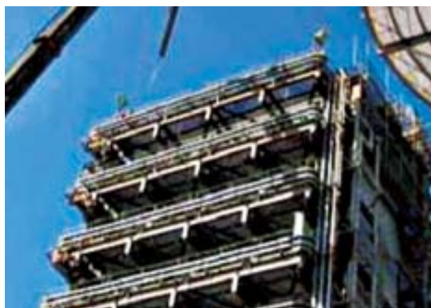
中龍第二號燒結廠SCR觸媒添加案觸媒吊裝圖
