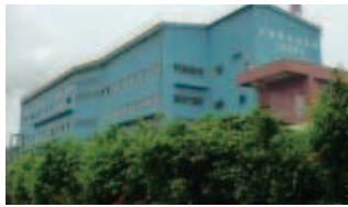
中鋼污水回收純化場
