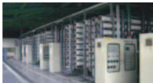
污水回收純化場內部
