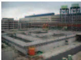
中龍煉鋼水場
