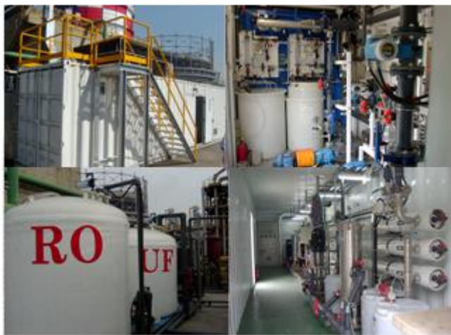
圖 6 300 CMD UF + RO 示范廠
