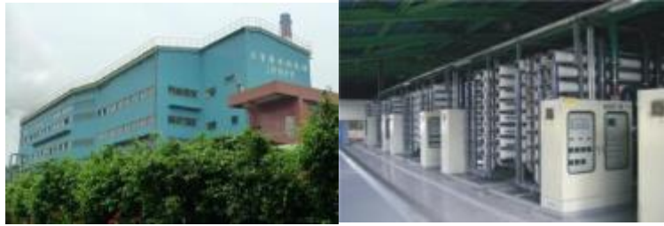
中鋼工業污水回收純化場外觀 中鋼工業污水回收純化場內部
