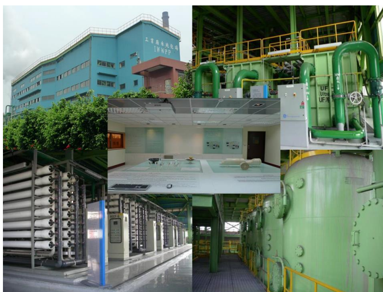
圖 7 13,500CMD 廢水回收廠
