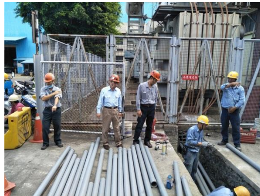
現場安全衛生聯合巡檢
